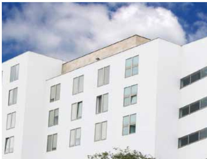
Trasera del Edificio de Ciencias Jurídicas
