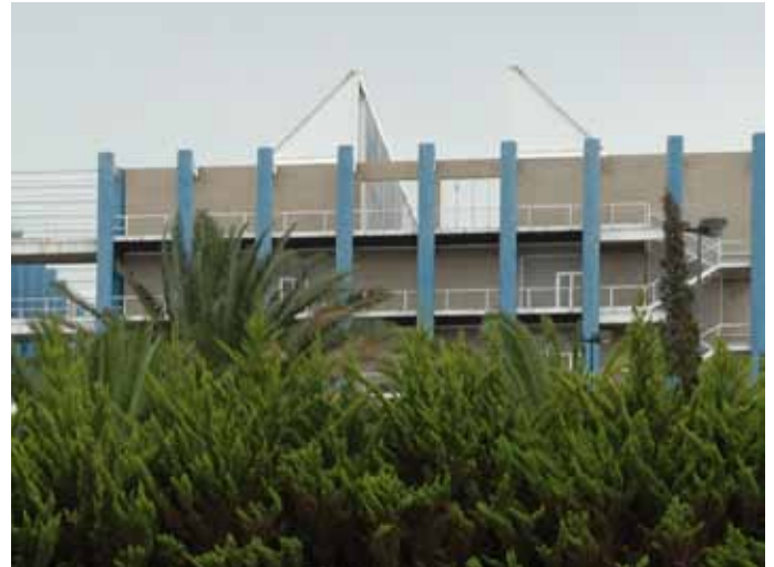
Detalle del Edificio de Ciencias Básicas
